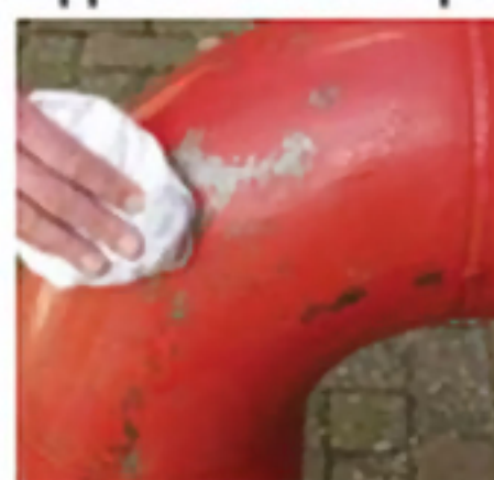
Rengöring och avfettning
